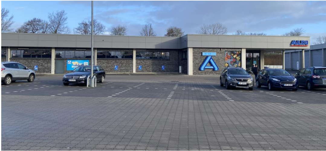
Abbildung 22: Aldi-Lebensmitteldiscounter an der Dithmarscher Straße im Gewerbegebiet Ost (Tönning)
